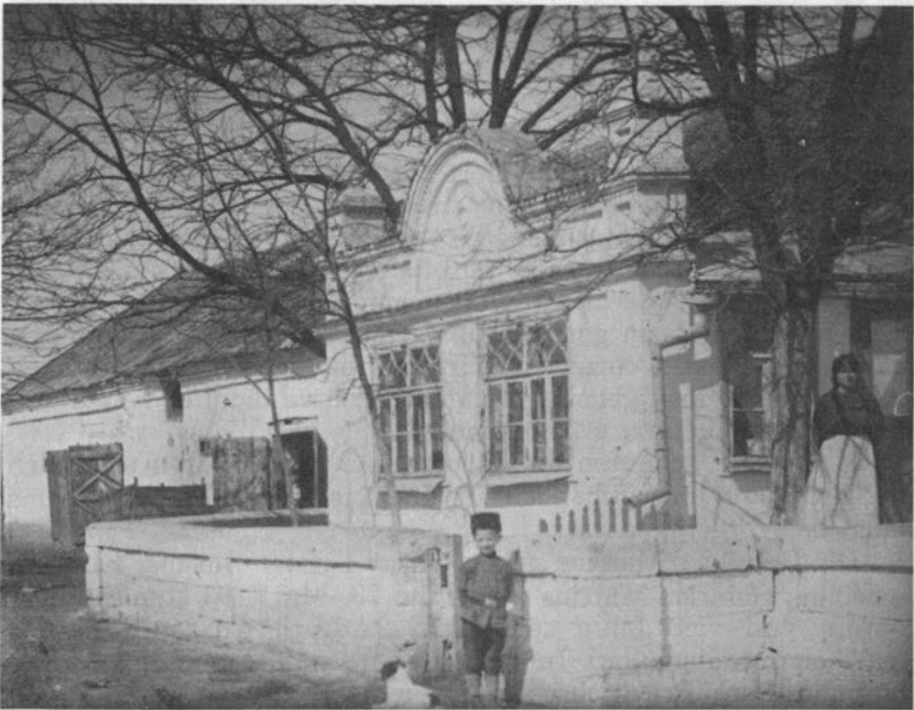
Wohnhaus von Heinrich und Anna Martins, Montanai. Vor der Tür des Koridors steht Tochter Tina als Mädchenschülerin. Vor dem Zaun steht Wilhelm, Sohn von Jakob und Margareta Martins, den wir bei uns großzogen. Eingesandt: M. Martins.
